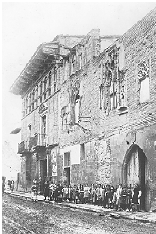
7.- Casa Palacio de Añués, aproximadamente en 1900. Fot. Archivo de Javier Beunza
