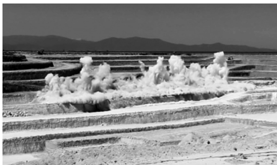
Imágenes 4 y 5. Tronadura en la cantera de caliza la Niña durante marzo de 2017 (elaboración propia).
