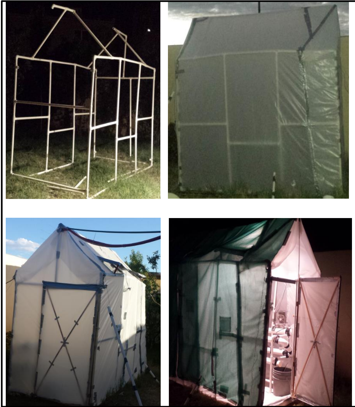
Figura 8.- Construcción del producto final
