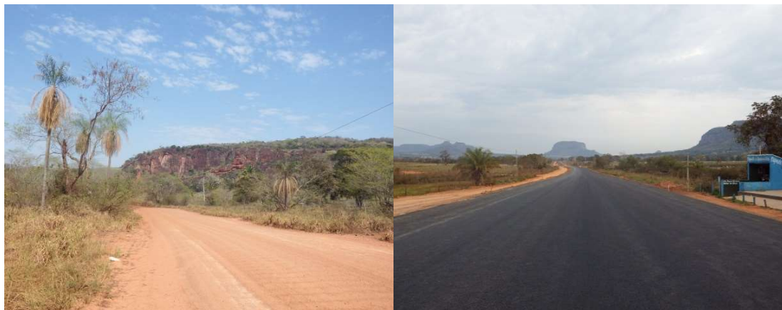
Figura 1: Visión Panorámica de la vía que atraviesa a todo lo largo el Parque de Piraputanga, a la izquierda el camino de tierra y a la derecha la nueva vía asfaltada
