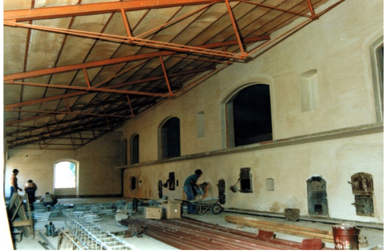
Fotografía durante la reforma
