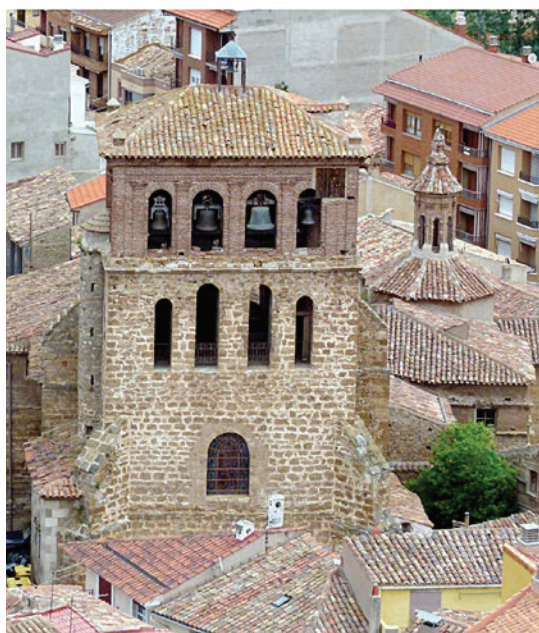
Ampliación de la torre campanario de la iglesia de San Gil y casa anexa (Cervera del Río Alhama)
