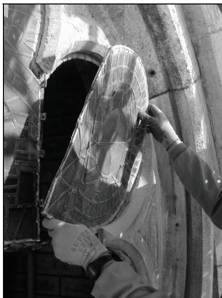
Desmontaje de un panel de vidriera para restaurar.
