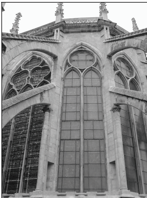
Vista exterior de vidriera restaurada.
