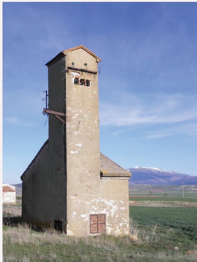
Antiguo transformador de Castilruiz.
