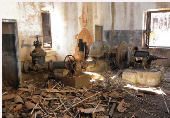
Lo poco que queda del interior de la central de Aldehuela.
