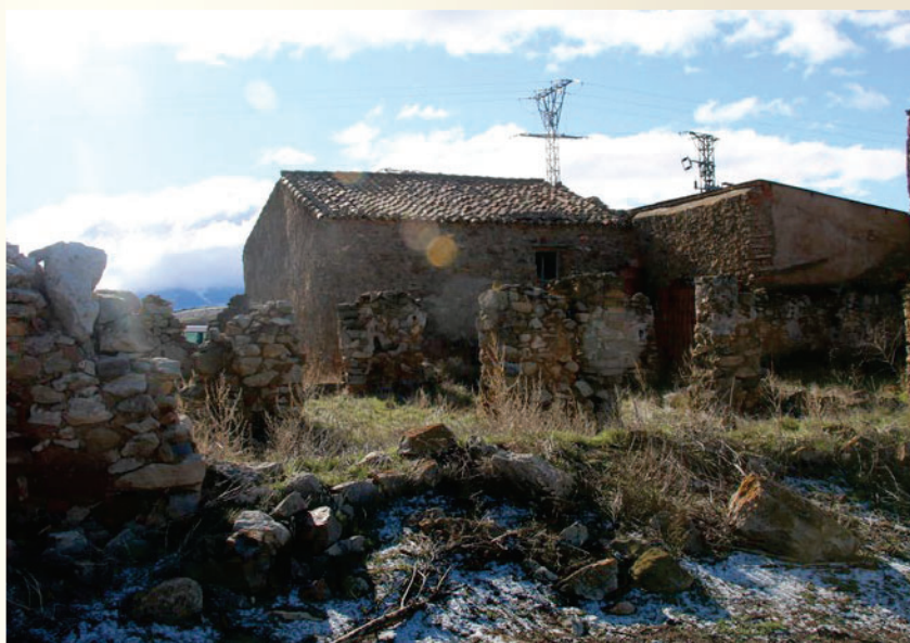
El estado ruinoso actual de la «casa de los toros»
