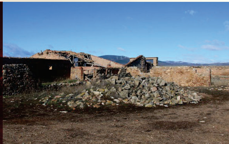
Vista exterior de las diferentes edificaciones.
