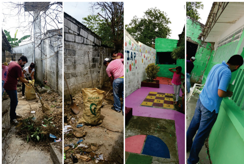
Imagen 5. Patio después de la intervención
