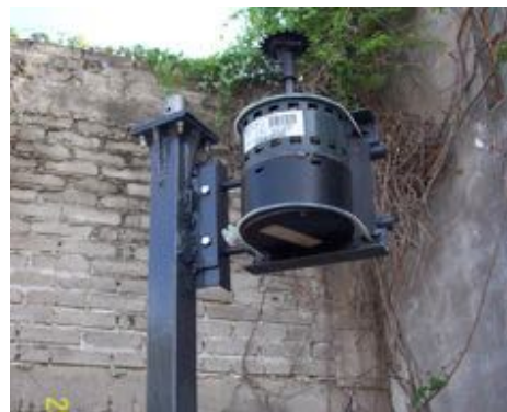
Figura 24 Montaje en su base y estructura.
