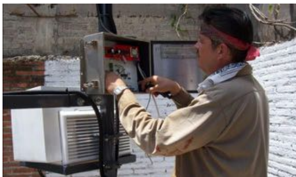
Figura 34a Montaje de caja en la base tubular.
