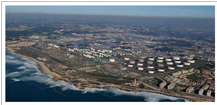
FIG. 24. Refinería de petróleo de Matosinhos (Galp). Fuente: < https://www.galp.com >.
