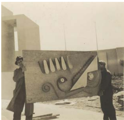
Montadores transportando una de las esculturas ubicadas en el pabellón del teatro del edificio Federal de Estados Unidos, en la Feria Mundial de Nueva York de 1939. (Archivo Peri Shaw).
