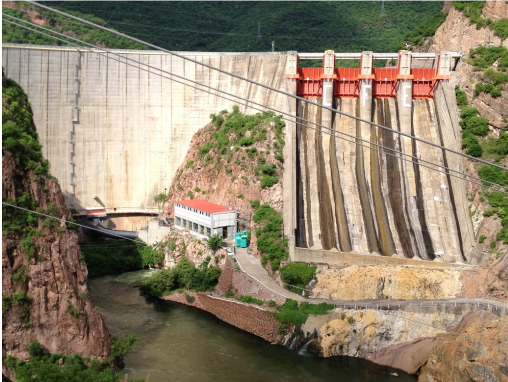
Figura 5. Vista de la cortina y el vertedor de la Presa Plutarco Elías Calles “El Novillo”
