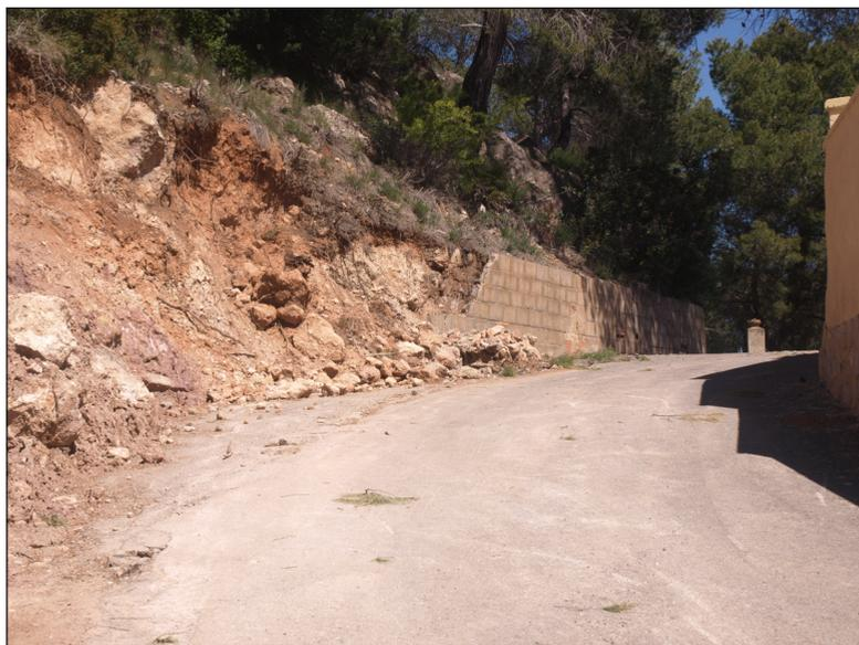
Figura 8. Derrumbe de un muro de protección del viario en una zona con mucha pendiente (Clot d' Oliver). Fotografía E. Burriel, junio de 2017.
