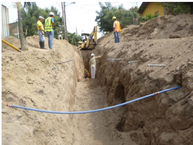
Foto 2. Limpiando el perfil de la zanja en Punto 12.
