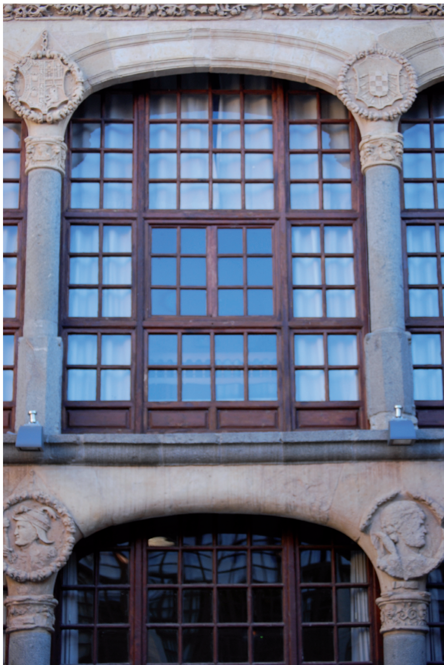
Fig. 10. Detalle de las columnas del patio.
