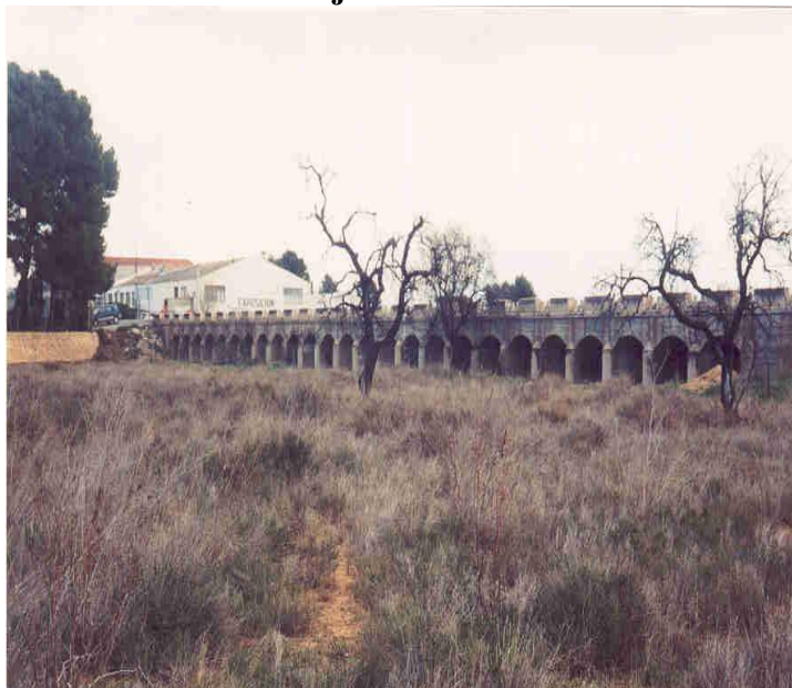
Foto 2. Fuente de los 25 ojos sobre la carretera de Caudete
