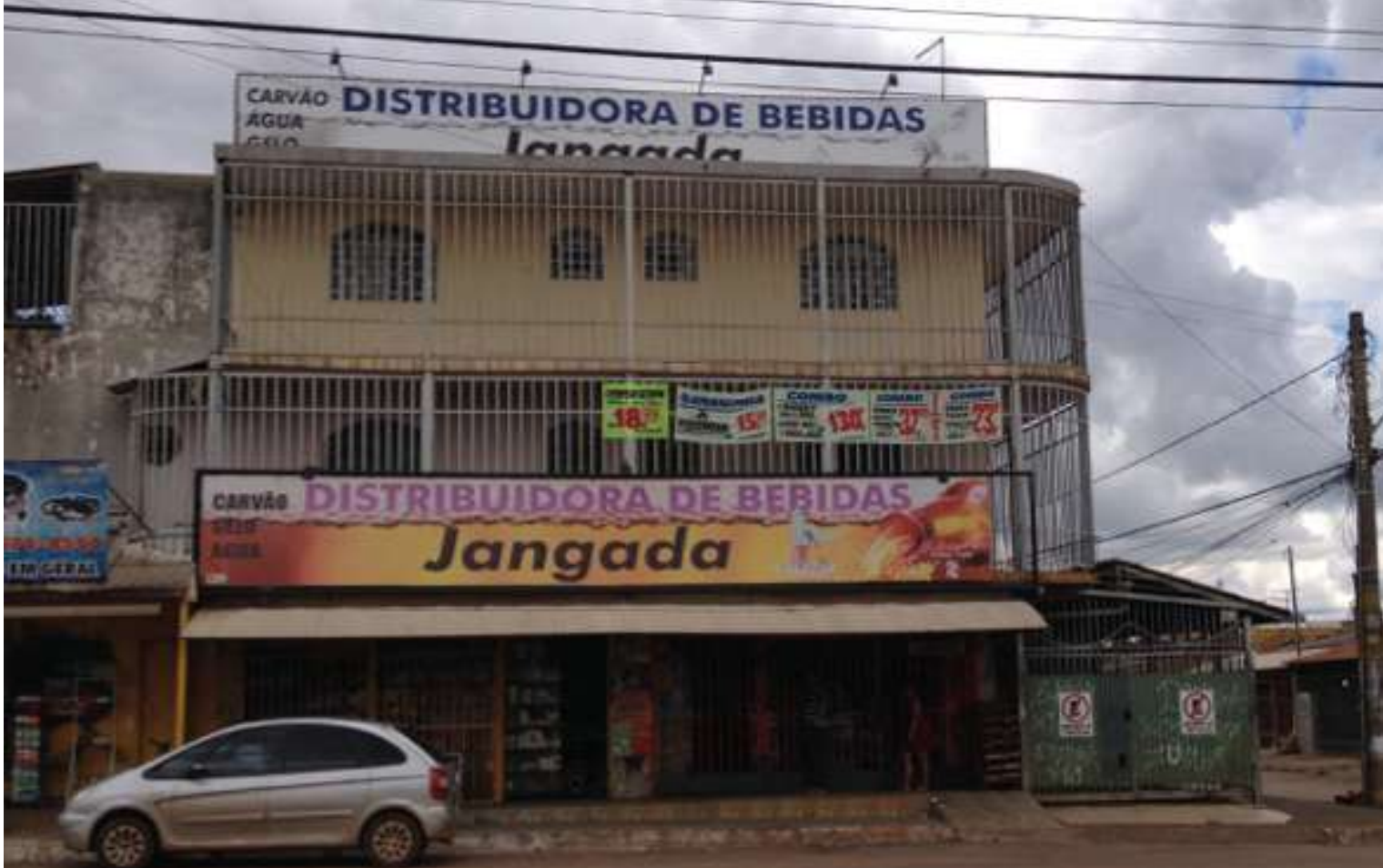
Figura 5. Ejemplo de rejilla-cortina en Ceilândia. Fuente: Foto acervo del autor.
