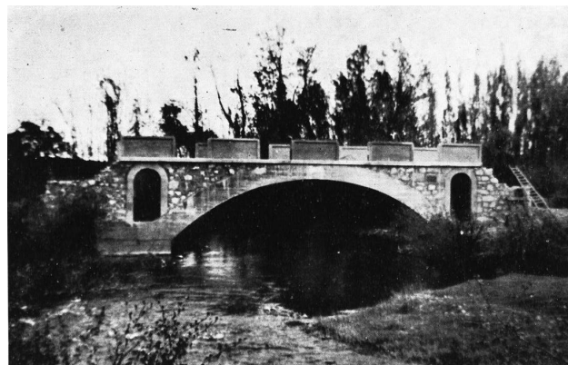
Construcción del puente sobre el río Tuerto entre Villaobispo y La Carrera. Memoria de la Diputación de León . 1950.
