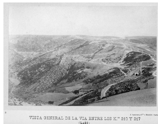
Los túneles del Manzanal. Fotografía de Laurent, 1883. Album de inauguración de la línea general de Galicia.
