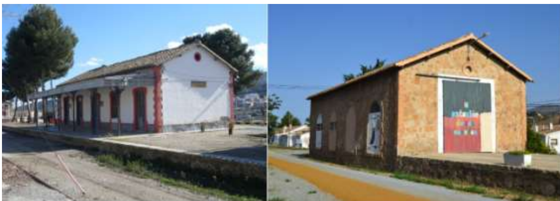
Figura 4. Naves en la línea de ferrocarril Lorca-Baza. Derecha, edificio de viajeros de la estación de Tíjola. Izqda., almacén en la estación de Serón (provincia de Almería)
