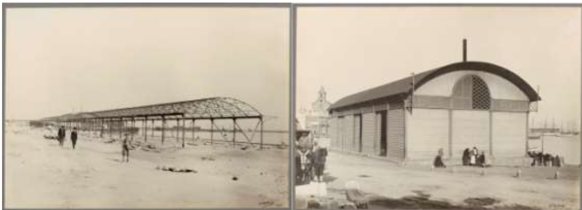
Figura 5. Tinglados metálicos del Puerto de Almería [12]. Biblioteca de la Universidad Politécnica de Madrid. Sede de la E.T.S. de Ingenieros de Caminos, Canales y Puertos.
