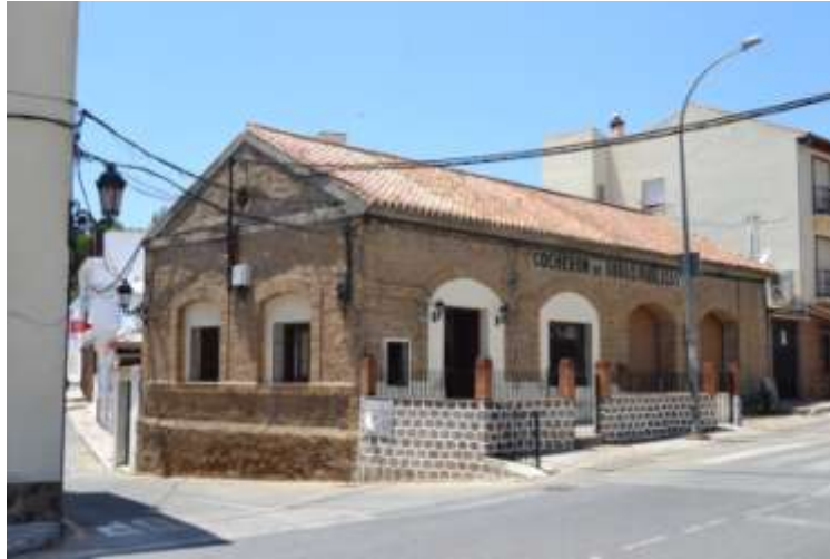
Figura 1. Nave para mantenimiento de carreteras en Colmenar (Málaga).
