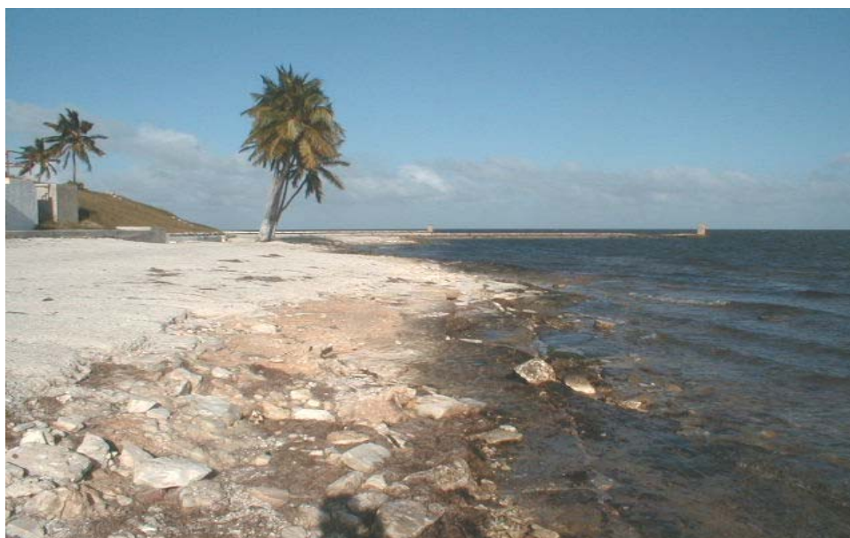
Figura 2: Estado actual del deterioro de la zona de baño de la playa Mar Azul, Caibarién
