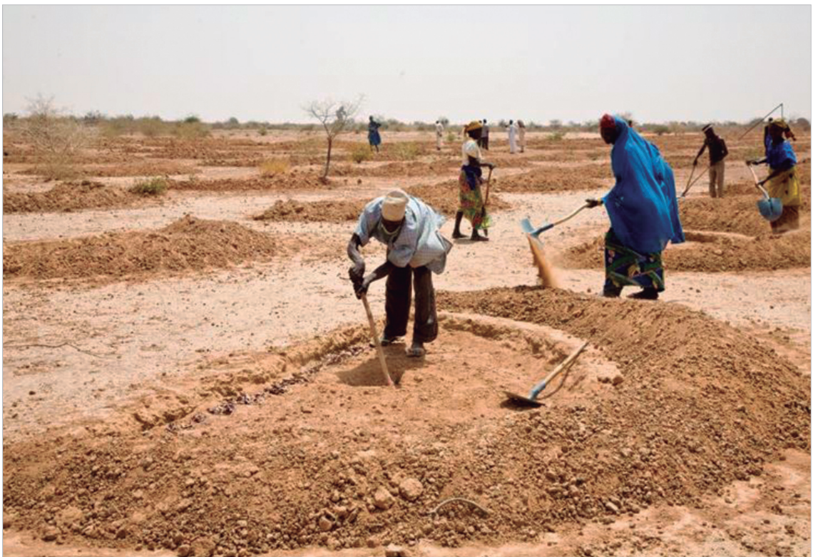
Figura 1. Construcción manual de caballones semicirculares en Níger (Fotografía: www.oxfam.org ).
