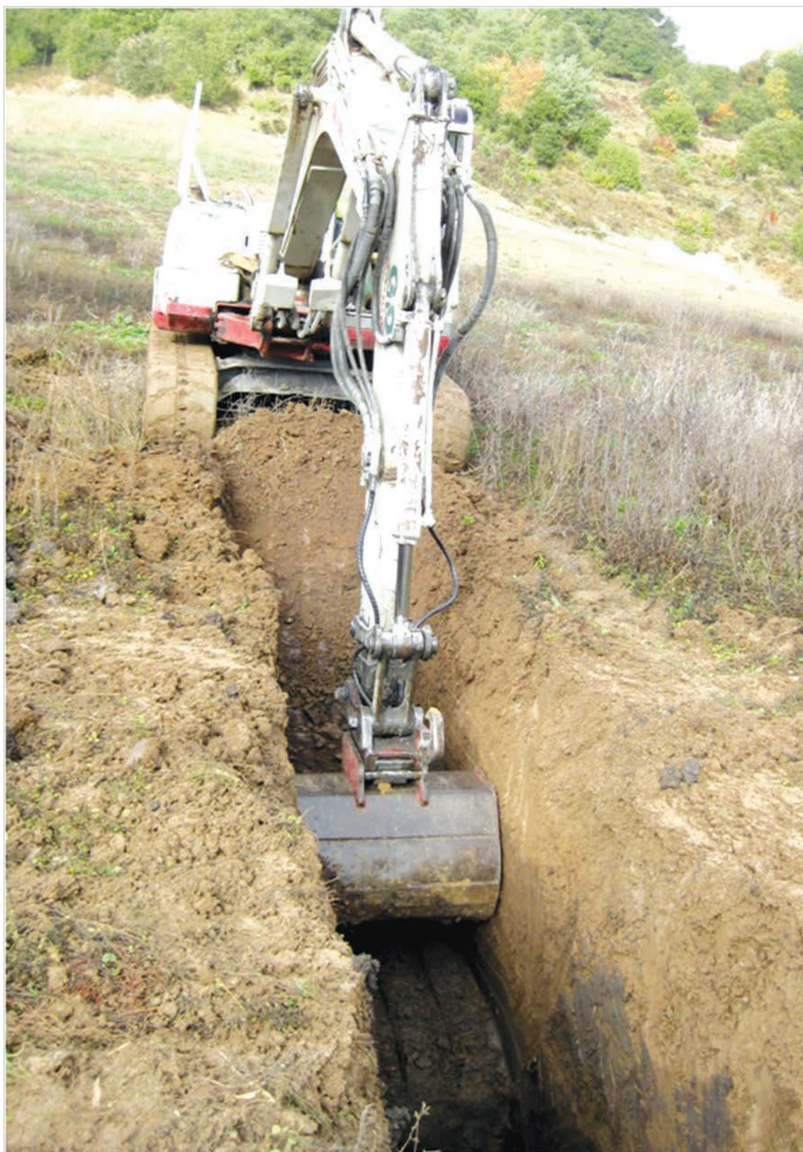
Figura 7. Cata realizada en obra para determinación del nivel de relleno artificial en el perímetro del lago.
