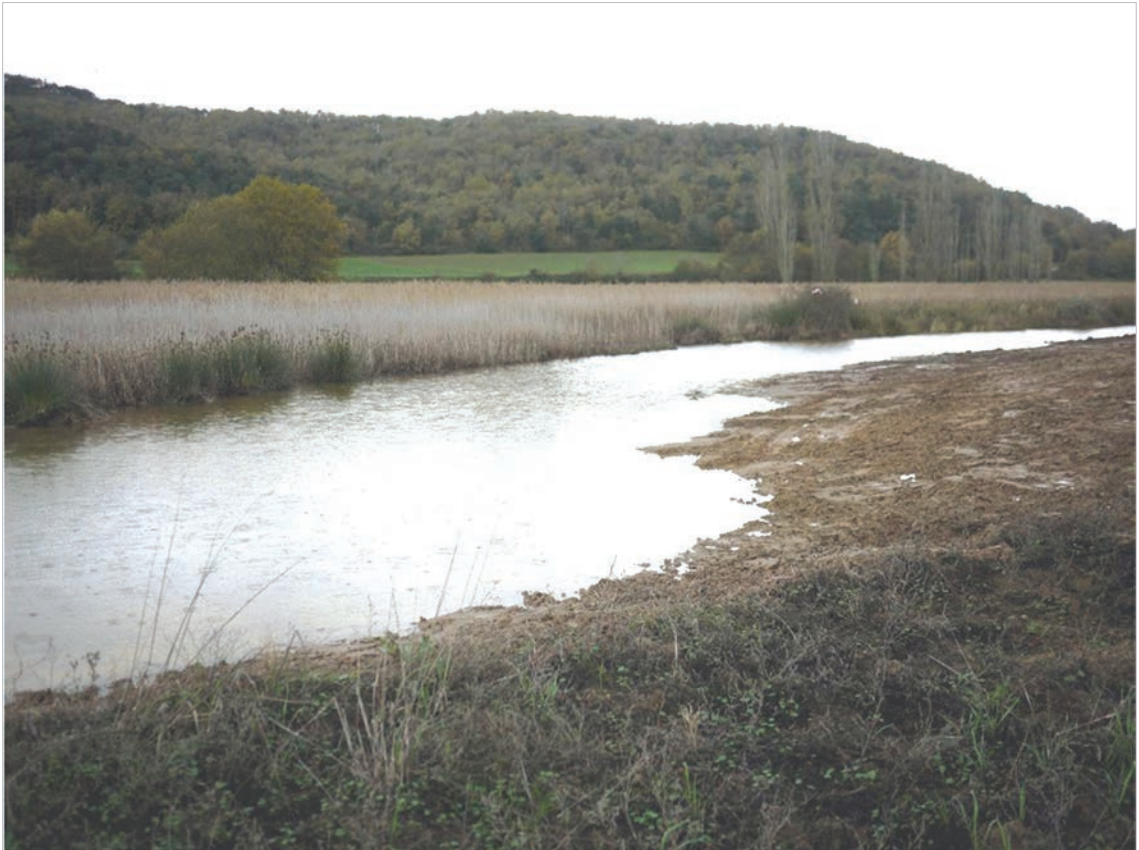
Figura 8. Área del vaso lagunar recuperada mediante excavación.
