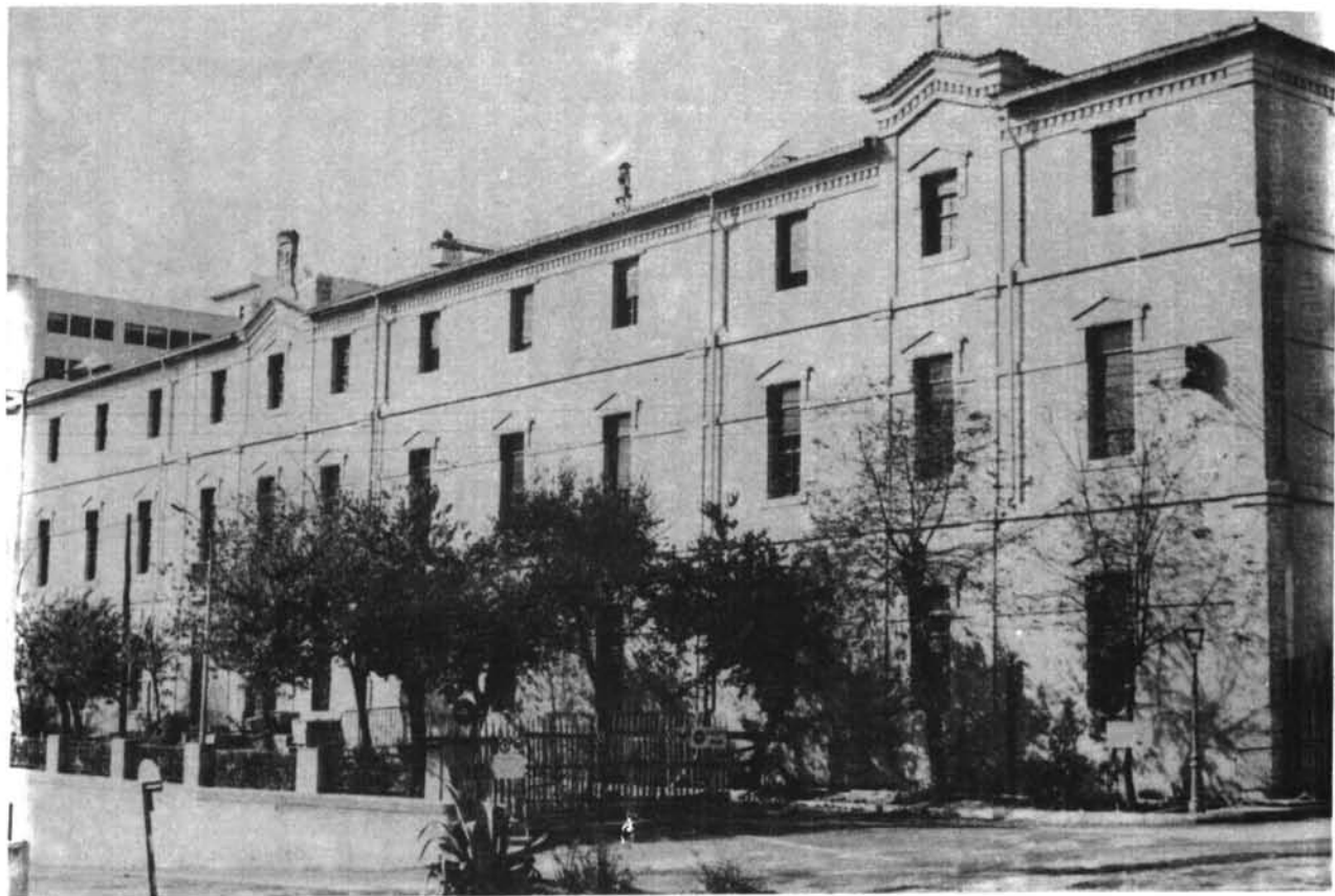
Fot. 3. Hospital Provincial (Cáceres)
