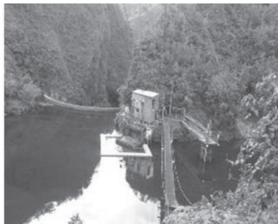
**Figura 7.** Sistema de retención en la zona de bocatoma – Embalse Tunjita.
