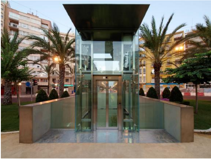
Estación TRAM Luceros, Alicante
