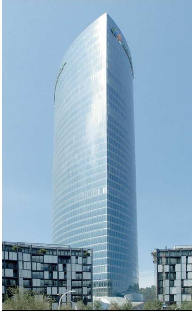
Torre Iberdrola, Bilbao
