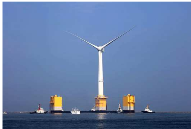
Semisumergible Turbina 7MW (Mitsubishi) Prevista operación Dic. 2015
