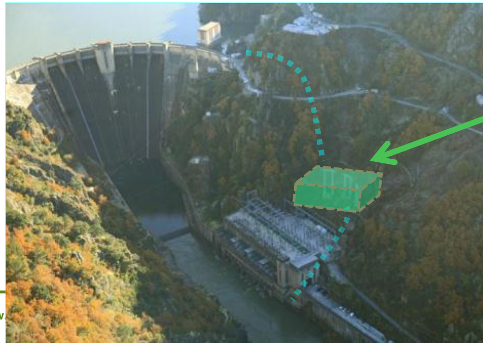
CH Santo Estevo II (subterránea)
