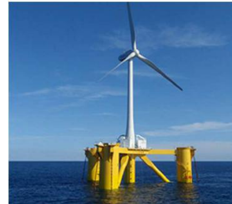
Semisumergible Turbina 2MW (Mitsui) Instalada Junio 2013
