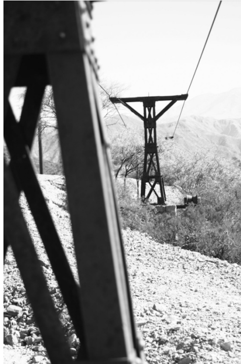
Imagen 3: Cablecarril en Chilecito, La Rioja. Fuente: Agalón Productora 2010.
