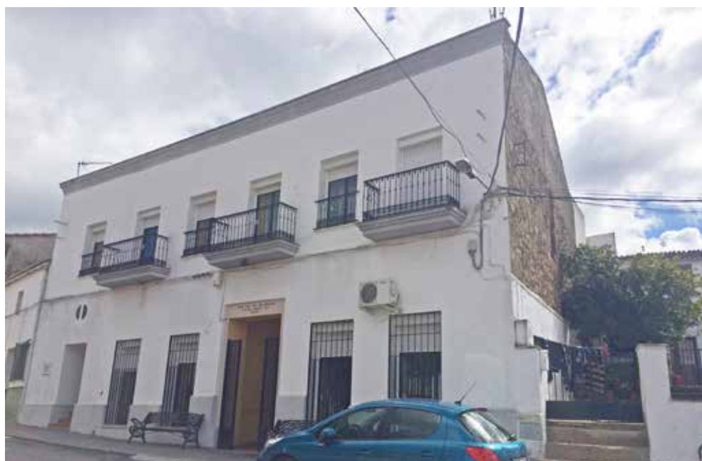
Antigua sede de la Sociedad Agraria, posteriormente la Casa del Pueblo y actuales Pisos Tutelados “Eladio Viñuelas”. Ibahernando.
