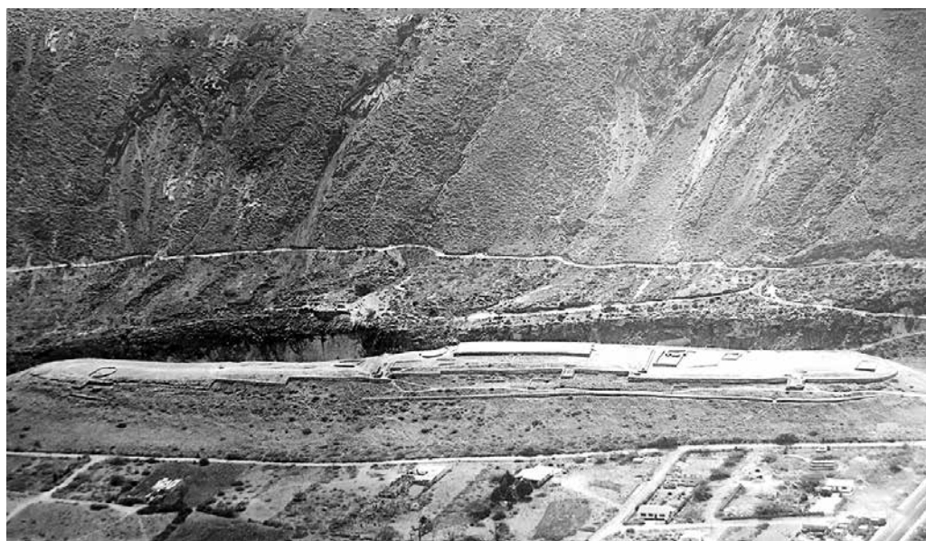
FOTO 2. VISTA DE FOTO PANORÁMICA DE LAS RUINAS DE RUMICUCHO, SAN ANTONIO DE PICHINCHA. DETALLE ARQUITECTÓNICO DE LA ANTIGUA FORTALEZA INCA. FOTO: ALEJANDRO RÍOS.
