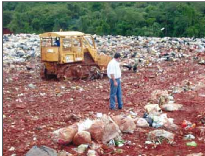
Figura 3: Aterro Sanitário de Apucarana/PR
