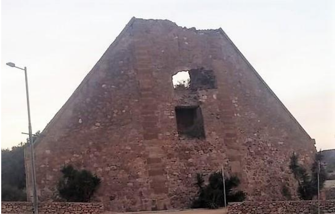
Cargadero de mineral
