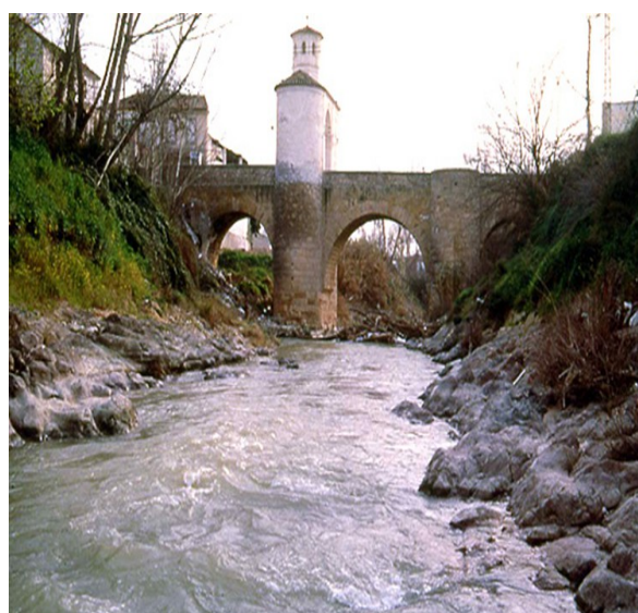
Puente Califal (Pinos Puente)
