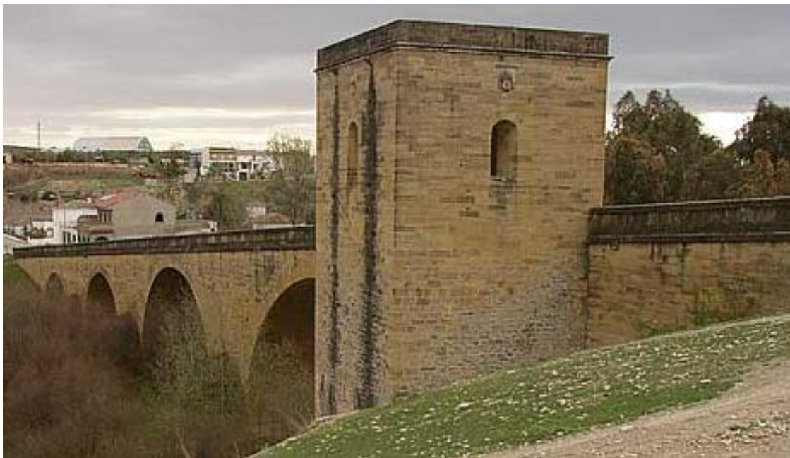
Puente del Obispo (Baeza)
