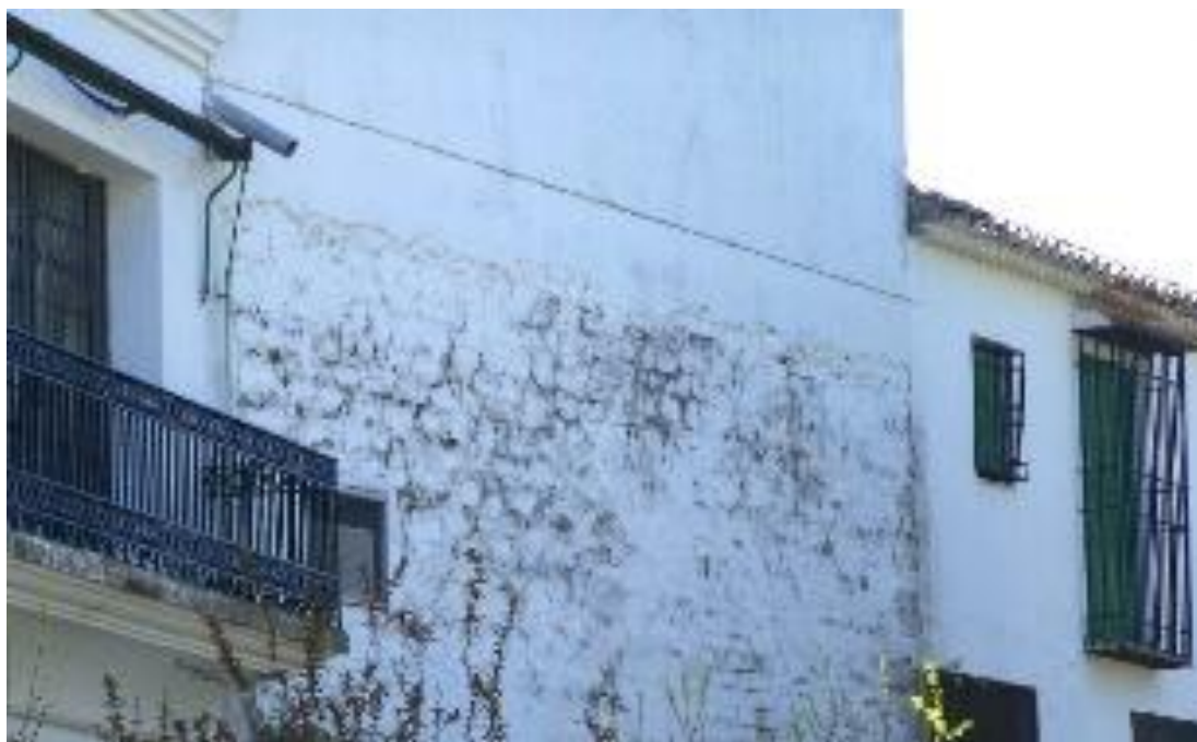
Restos de la Torre en el cortijo de Gil de Olid (Baeza).
