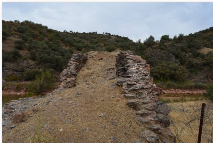
Calzada y arranque del pretil en el estribo sur
