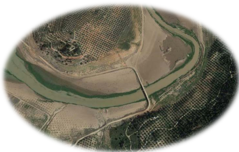
F1) Vista aérea del Puente Ariza
