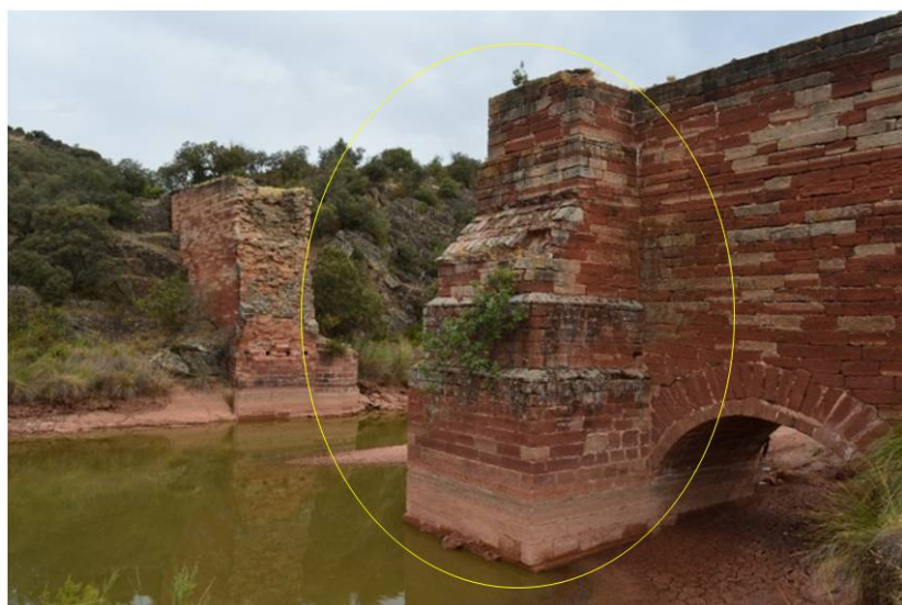
Vista del contrafuerte aguas abajo en el estribo sur
