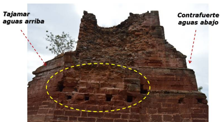
Arranque de arco de medio punto en el estribo sur
