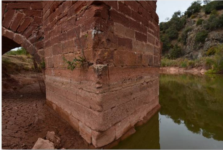
Vista del tajamar en forma de vértice, aguas arriba.
