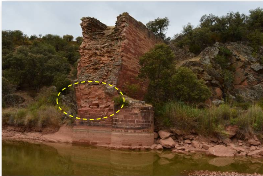
Arranque de arco de medio punto en el estribo norte
