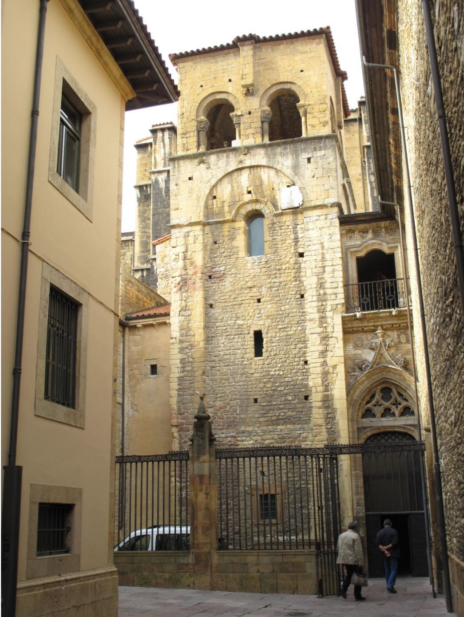
Fig. 1. Catedral de Oviedo. Vista de la fachada sur de la torre vieja.
