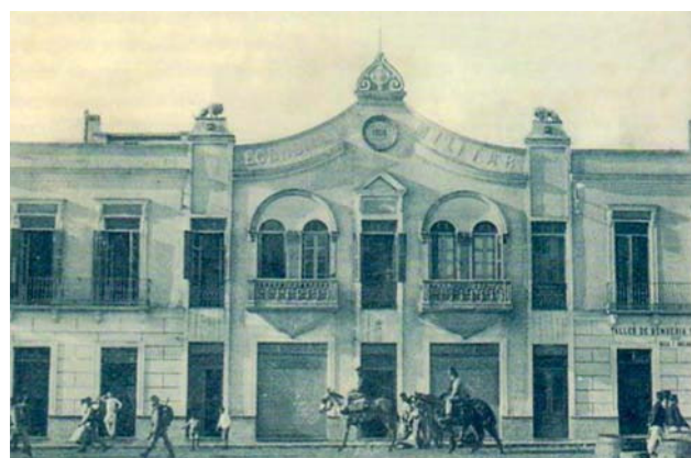
(Figura 12) Antigua fachada del Economato Militar antes de ser intervenida por Nieto, obra de Rodríguez Borlado (1907). Fuente: Camacho Martínez 2006: 780.
