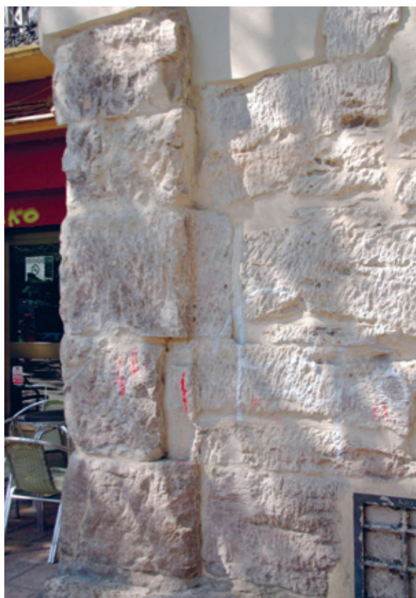
14. Entalle en la jamba de la puerta.
