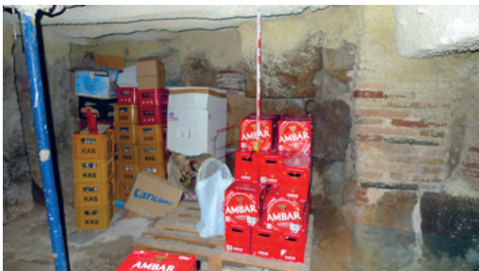
15. Sótano de Coso 147 (antiguo 153). Paramento norte.
