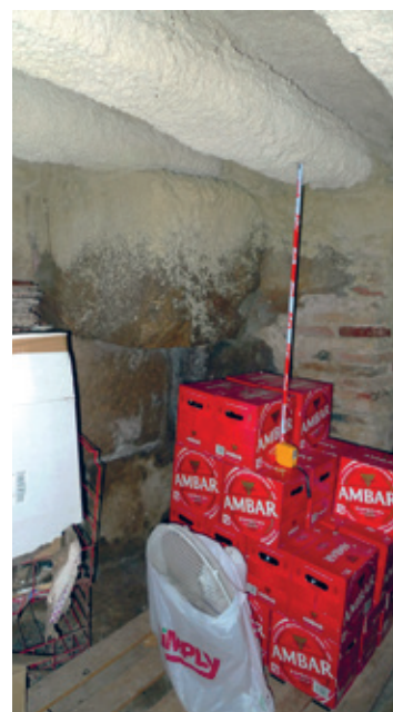
18. Sótano de Coso 147 (antiguo 153). Detalle del paramento norte.
