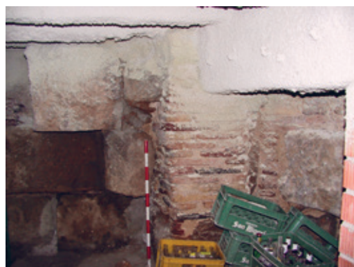
16. Sótano de Coso 147 (antiguo 153). Detalle del paramento norte.
