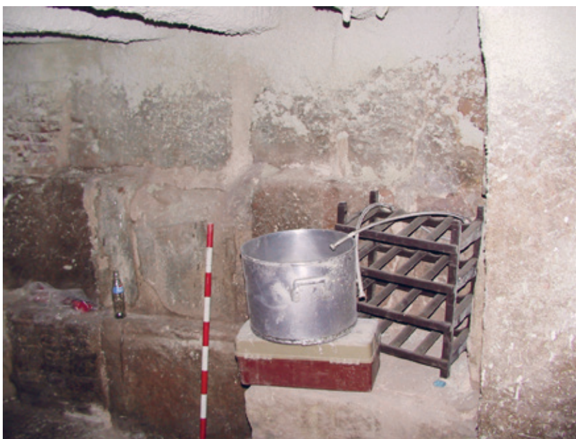
17. Sótano de Coso 147 (antiguo 153). Paramento oeste.
