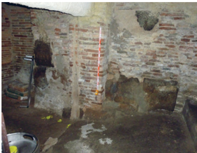
19. Sótano de Coso 147 (antiguo 153). Paramento sur.
