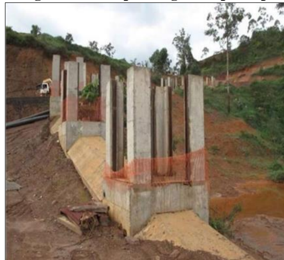
Fotografia 9: Tulipas da galeria principal.
