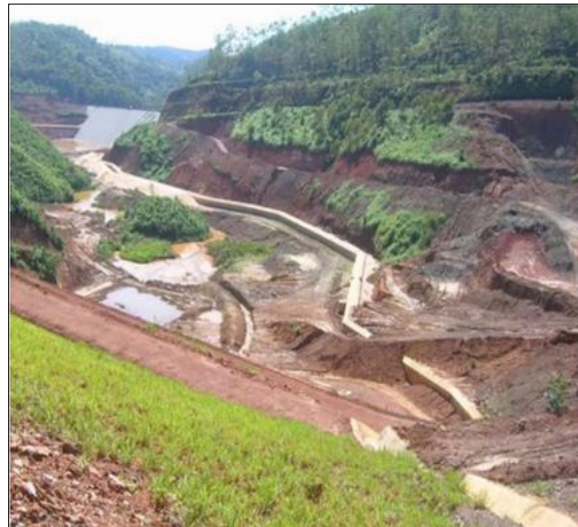
Fotografia 8: Galeria principal, com o Dique 1 ao fundo.
