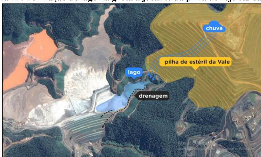
Figura 17: Formação de lago na grota a jusante da pilha de rejeitos da Vale.
