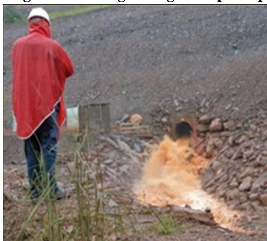
Fotografia 6: Deságue da galeria principal.
