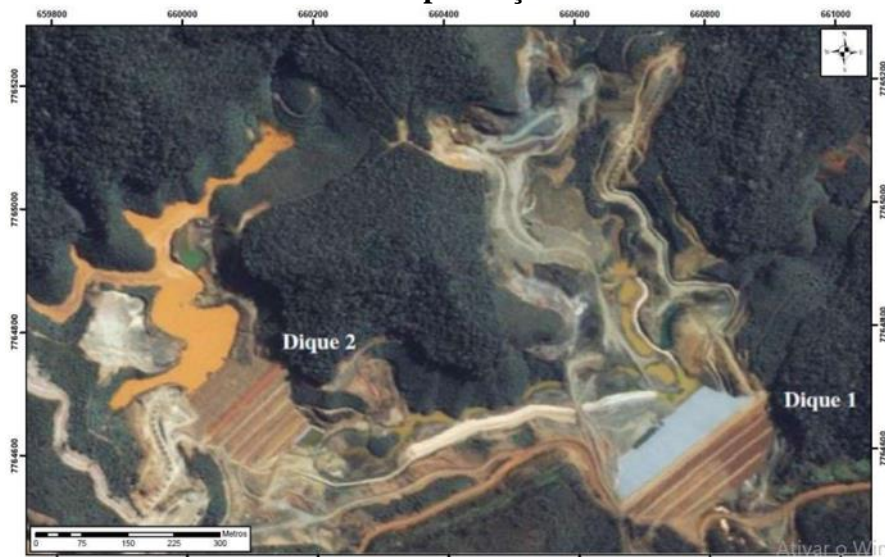
Figura 5: Barragem do Fundão. Vista geral no ano de 2008, imediatamente após sua implantação.
