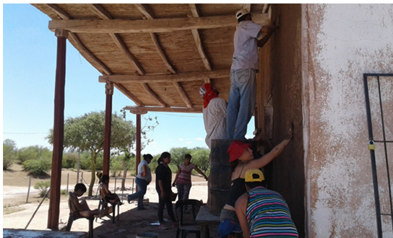
Fig. 1. La autora, junto con nativos, participando de la restauración comunitaria de la capilla (marzo de 2017). Se armó un piletón de barro que fue usado por los niños para juegos mientras revolvían la mezcla de barro. Al finalizar la jornada de trabajo compartimos una cena. Esta actividad tuvo un alto impacto en medios periodísticos locales.
