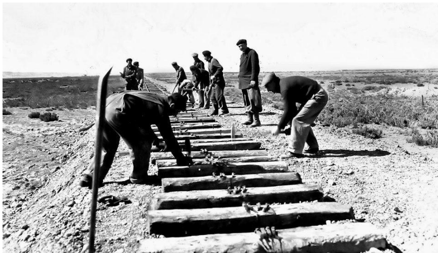
Figura 6: Construcción del RFIRT.
