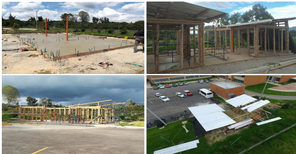
Figura 5. Proceso Constructivo Vivienda ECO Sostenible.
