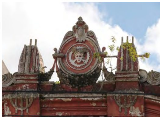
Figura 3 – Detalhes da fachada principal do CCRG
