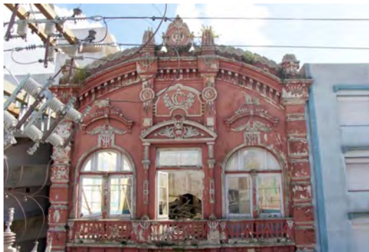
Figura 4 – Detalhes da fachada principal do CCRG
