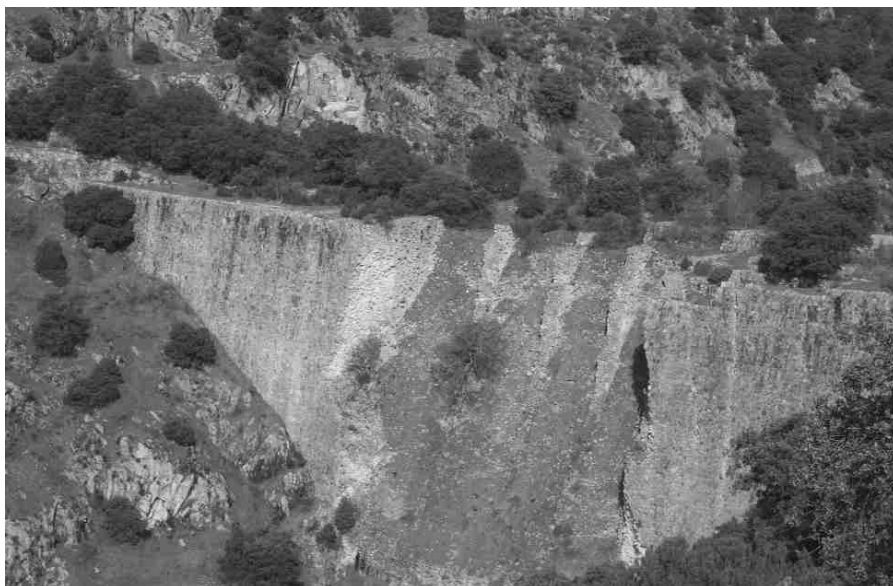
Vista de la Presa del Gasco en la cabecera del Canal del Guadarrama, destruida por una tormenta el 14 de mayo de 1799.
