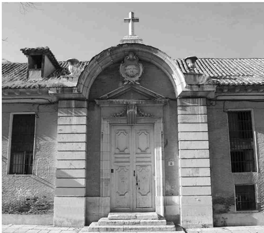
Fachada del Hospital San Carlos de Aranjuez
