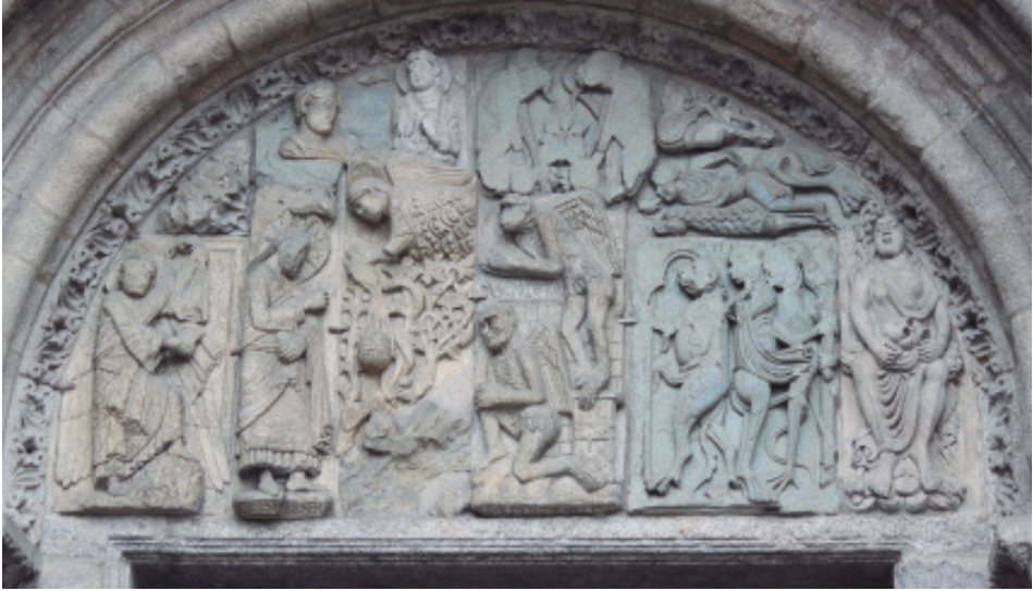
Fig. 16. Tímpano izquierdo de la Puerta de Platerías con piezas instaladas sin orden ni concierto, donde está empotrada de mala manera la Betsabé conocida como mujer adúltera . Foto: Erias.
