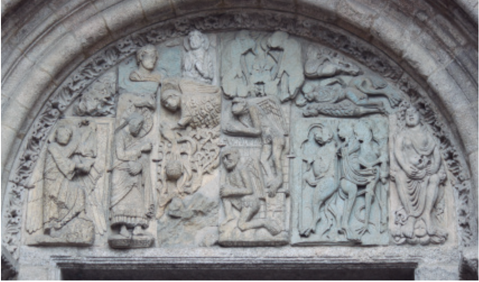
Fig. 16. Tímpano esquerdo da Porta de Praterías con pezas instaladas sen orde nin concerto, onde está empotrada de mala maneira a Betsabé coñecida como muller adúltera . Foto: Erias.
