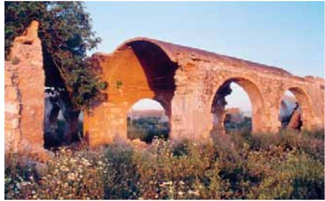
13. SOLUCIÓN DE CUBIERTA MEDIANTE BÓVEDA CONTINUA DE LADRILLO APOYADA SOBRE ARQUERÍAS. EN ESTE CASO EL EXTRADÓS DE LA CUBIERTA QUEDA VISTO SIN RECUBRIMIENTO DE TEJA.
