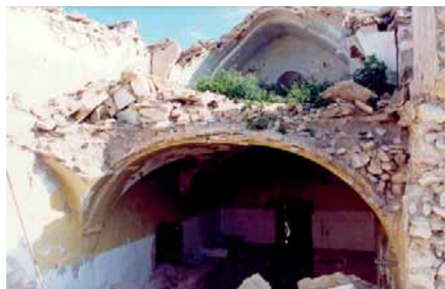
7. BÓVEDAS DE FORJADO INTERMEDIO Y CUBIERTA.
