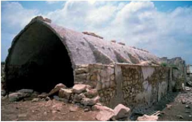
12. CUBIERTA A DOS AGUAS CONSTRUIDA MEDIANTE BÓVEDA CONTINUA DE LADRILLO DE DIRECTRIZ APUNTADA APOYADA SOBRE LOS MUROS LATERALES. SE OBSERVAN LOS NERVIOS DE REFUERZO PERPENDICULARES A LA DIRECTRIZ DE LA CÚPULA Y QUE REPARTEN EL EMPUJE SOBRE LA CORONACIÓN DEL MURO.
