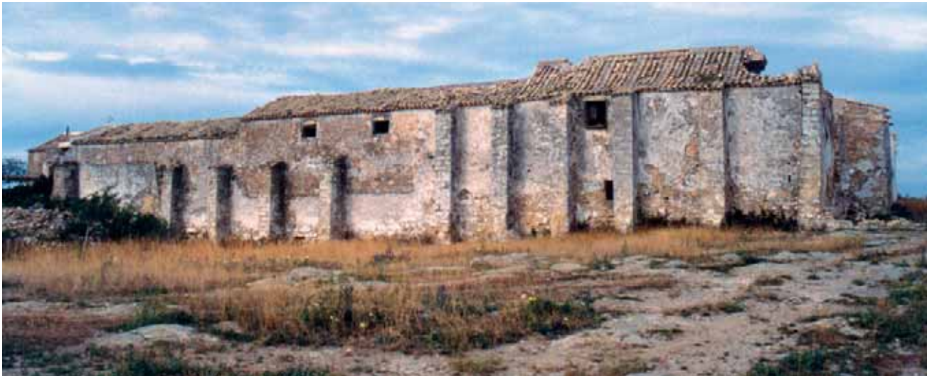
1. MURO DE MAMPOSTERÍA ORDINARIA CON CONTRAFUERTE DE REFUERZO.
