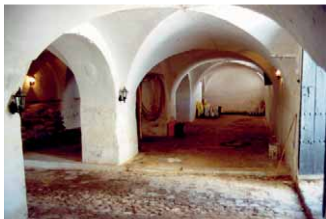
6. FORJADO HORIZONTAL RESUELTO CON BÓVEDAS DE ARISTA.
