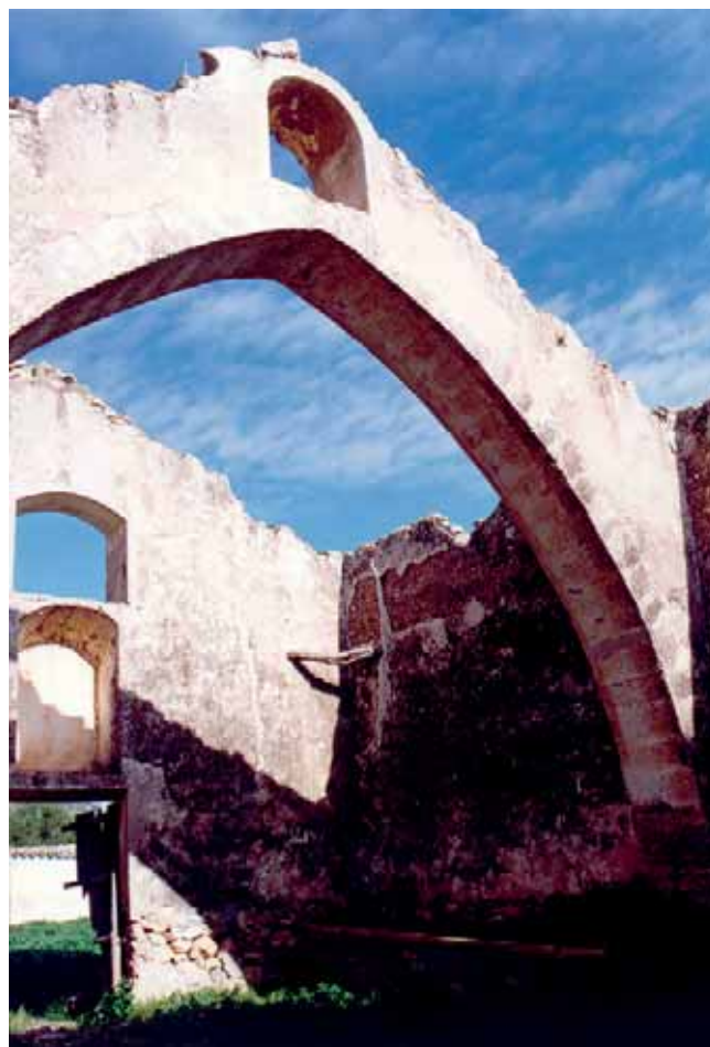
11. MUROS DE TAPIAL, ARQUERÍA DE MAMPOSTERÍA DE SILLAREJOS Y MUROS DE MAMPOSTERÍA ORDINARIA.
