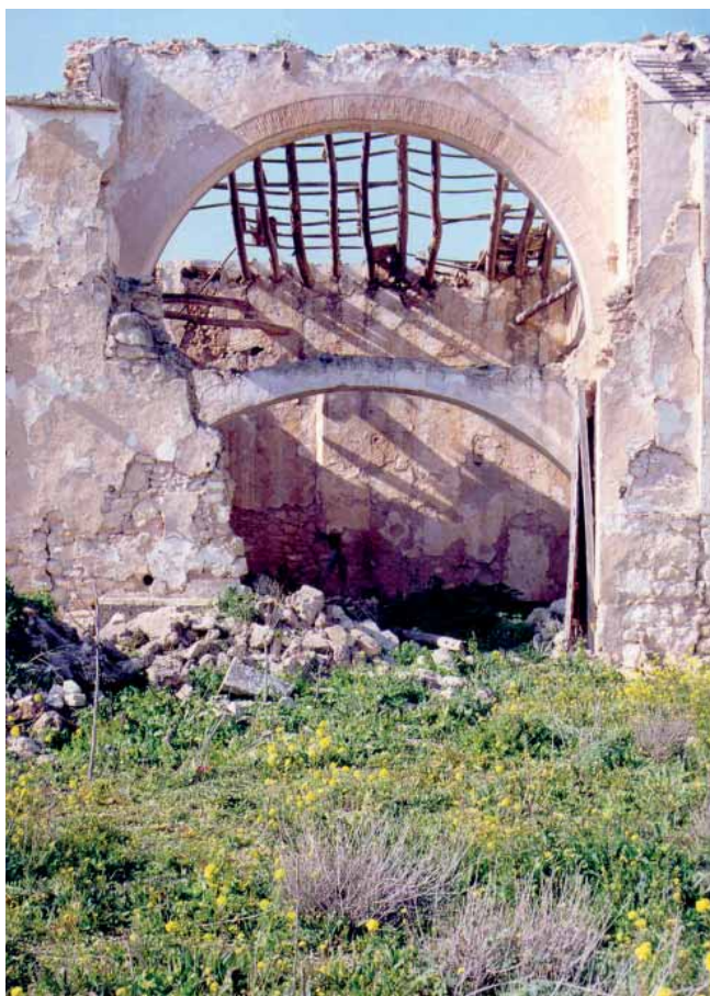
3. MURO INTERMEDIO DE NAVE DE ALMAZARA CONSTRUIDO CON MAMPOSTERÍA ORDINARIA Y ARCOS DE LADRILLO MACIZO.
