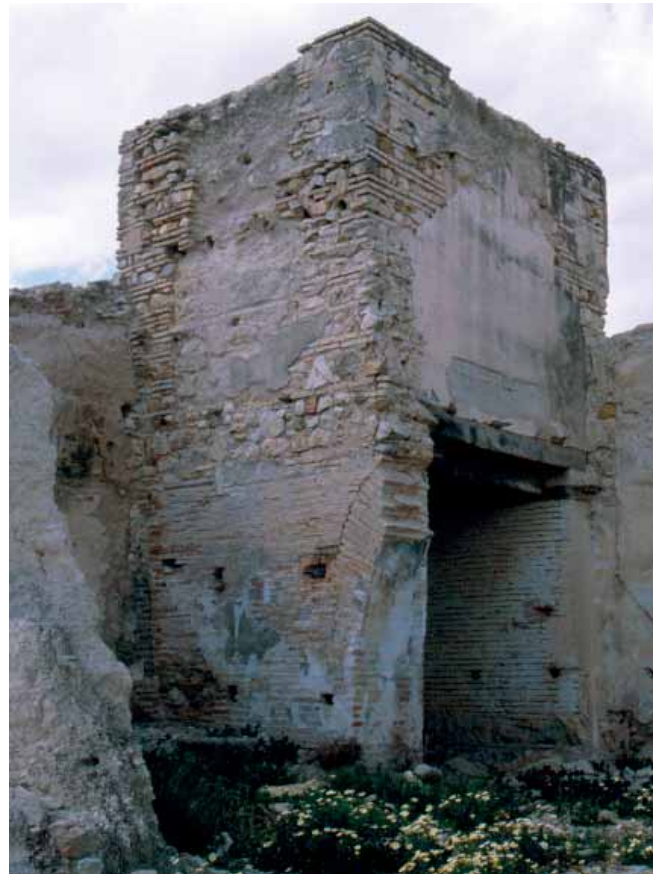
2. TORRE DE ALMAZARA CONSTRUIDA CON UNA TÉCNICA MIXTA, MUROS DE ARRANQUE DE FÁBRICA DE LADRILLO MACIZO, MASA DE CONTRAPESO REALIZADA CON TAPIAL Y REFUERZOS DE LADRILLO MACIZO.
