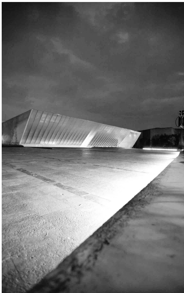
FIGURA 2. Aspecto exterior del MUAC-UNAM. (Fotografía: Barry Domínguez; cortesía: MUAC-UNAM).
